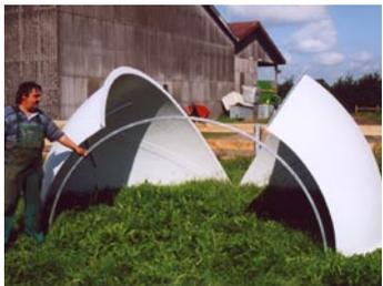
Transportez toutes les pièces à un endroit plan. Commencez par mettre les tubes qui serviront à la ventilation dans les ouvertures prévues à cet effet et déposez du silicone afin d'assurer l'étanchéité.
